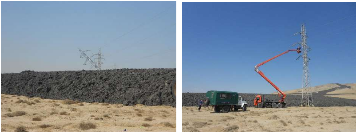
Şəkil 14. Vulkanından sonuncu püskürməsi nəticəsində sıradan çıxan elektrik dirəkləri
